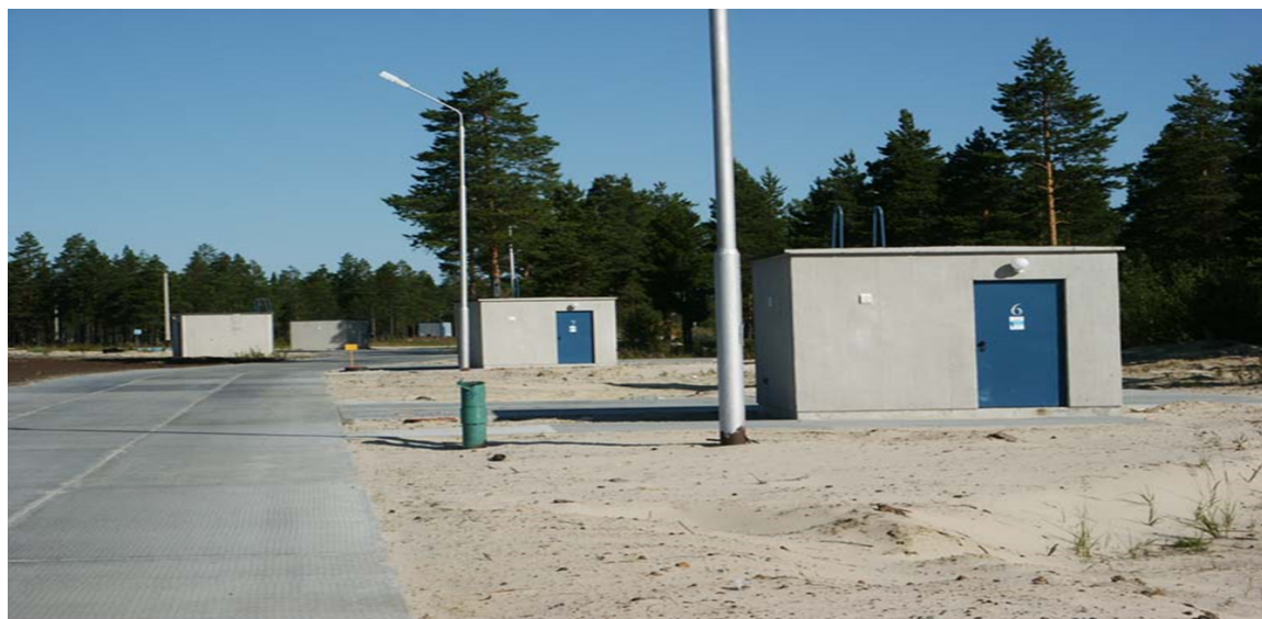
Рисунок 8. Общий вид скважинных павильонов
